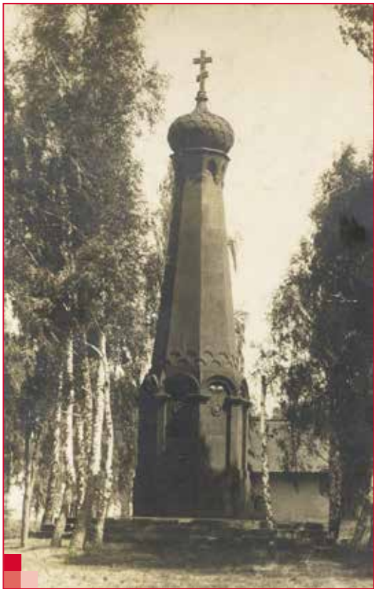
Ryc. 4. Pomnik wzniesiony przez władze carskie w Jakaci. W 1925 r. został on zdemontowany i przewieziony na Plac Pocztowy w Łomży, gdzie po przebudowie miał służyć jako pomnik Bohaterom Obroncom Ojczyzny
