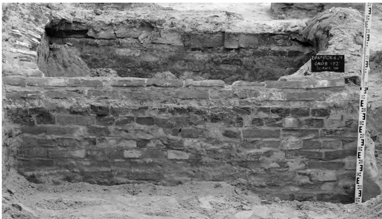
Fot. 28. Białystok, cmentarz ewangelicki przy ul. Młynowej. Grób nr 182 (krypta murowana): 1 – krypta po usunięciu warstwy bruku kamiennego; sklepienie uległo zniszczeniu w czasie funkcjonowania placu targowego; 2 – południowo-zachodnia ściana krypty
