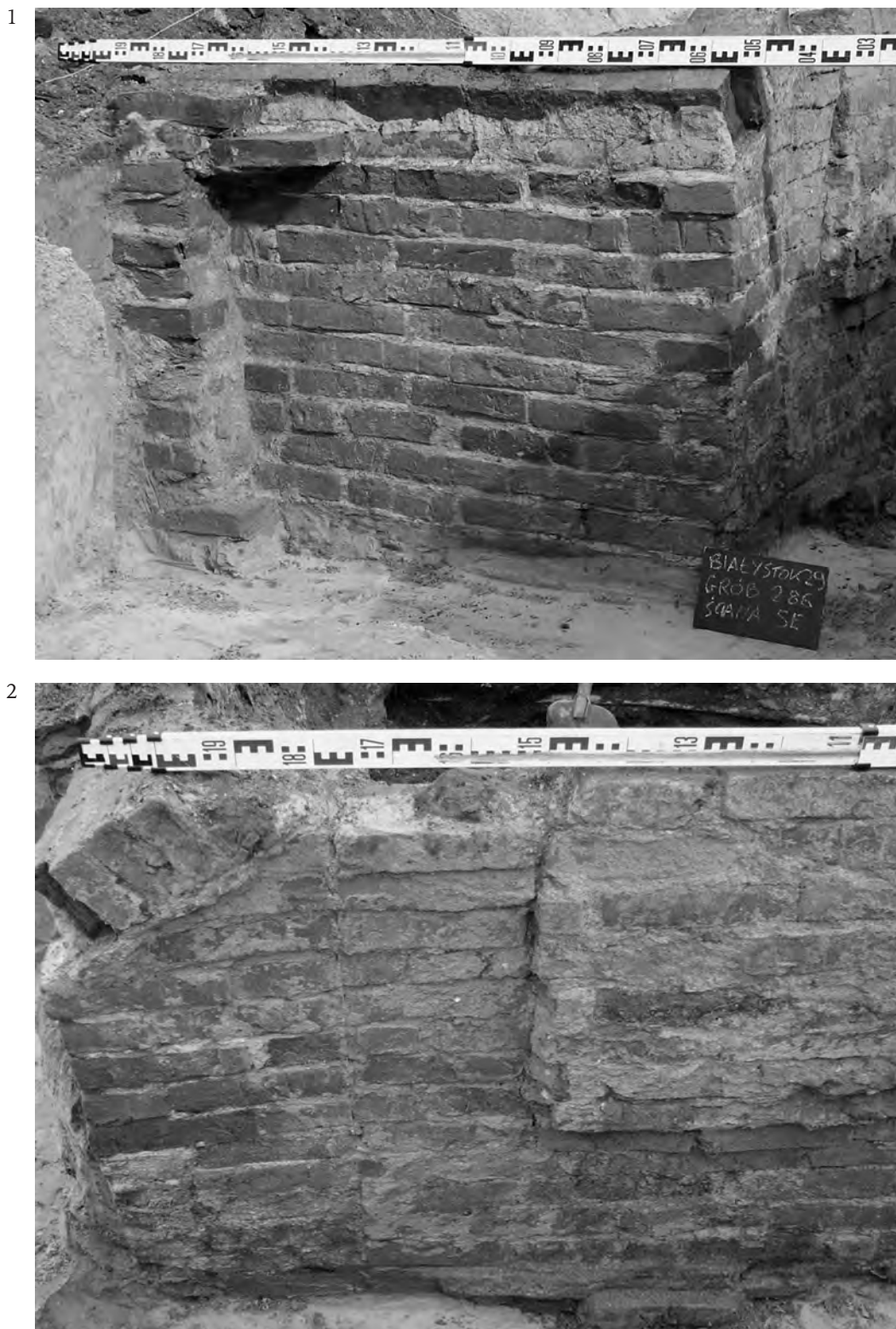
Fot. 44. Białystok, cmentarz ewangelicki przy ul. Młynowej. Groby 286A i 286B (krypta murowana): 1 – południowo-wschodnia ściana krypty; 2 – południowo-zachodnia ściana krypty
