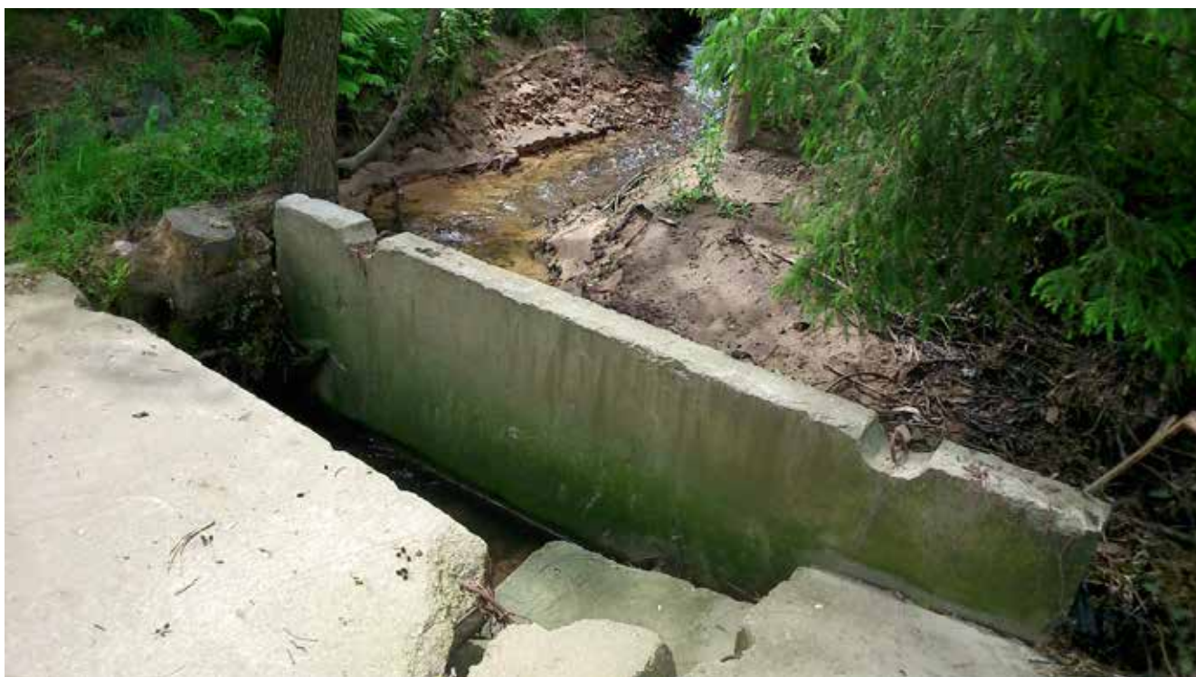
RYC. 23. Prowizoryczna zapora i przeprawa przez Kamionkę zbudowana z betonowych płyt w górnym odcinku rzeki w Zaciszowicach. Fot. P. Przepióra 2014
