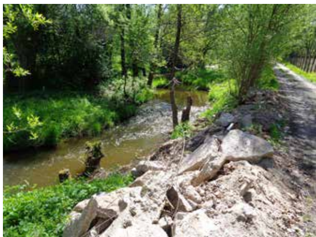
RYC. 81. Zabezpieczanie dojazdu do ogródków działkowych przy użyciu resztek budowlanych na brzegu rzeki. Fot. P. Przepióra 2014
